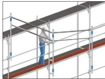
Monteringsrekkverket flyttes opp etterhvert som monteringen skrider frem.
