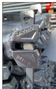
Kilehoder på rigler, u-rigler, diagonaler og andre deler med kilehode.
